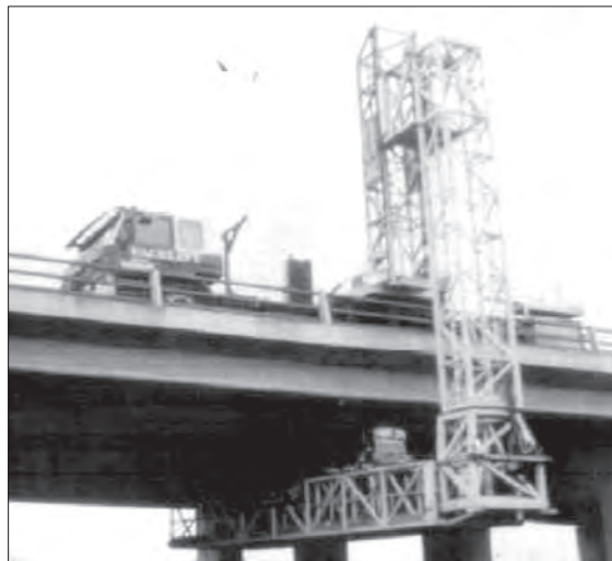
شکل ۳: بازرسی از پل ها با استفاده از بتاترون [۴]
