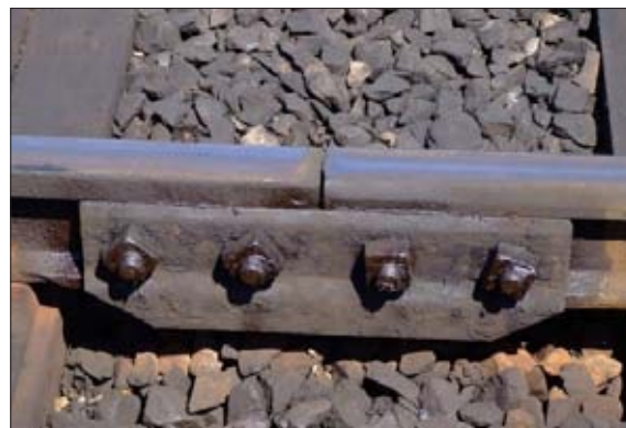
شکل ۱- اتصال پیچ دار و صفحات پوششی
