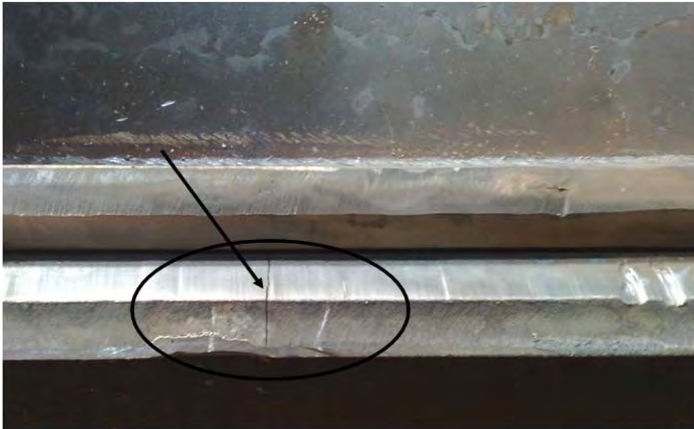
شکل-۲۴۵: ایجاد ترک در متریال CK45 بر اثر عدم پیشگرم قبل از عملیات برشکاری
