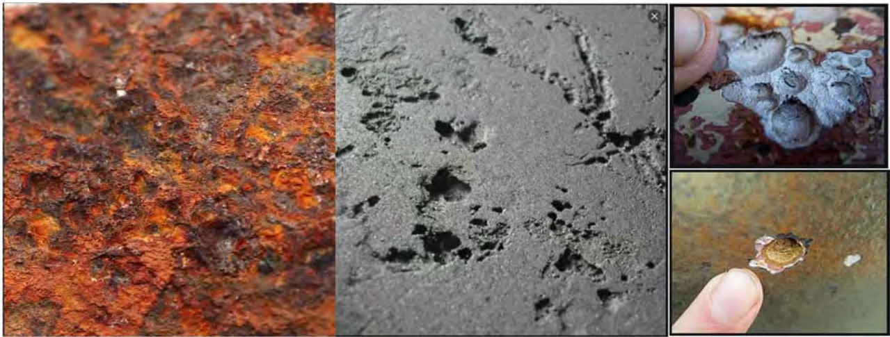
شکل-۲۸۵: نماهایی از حفره های خوردگی ایجاد شده روی سطح ورق
