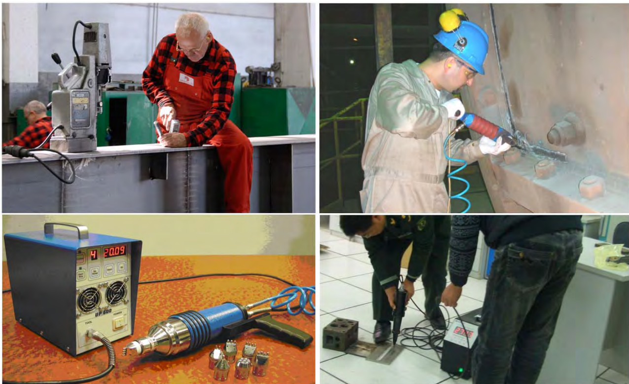
شکل-۲۳۷: انجام عملیات Peening با روشهای متفاوت
