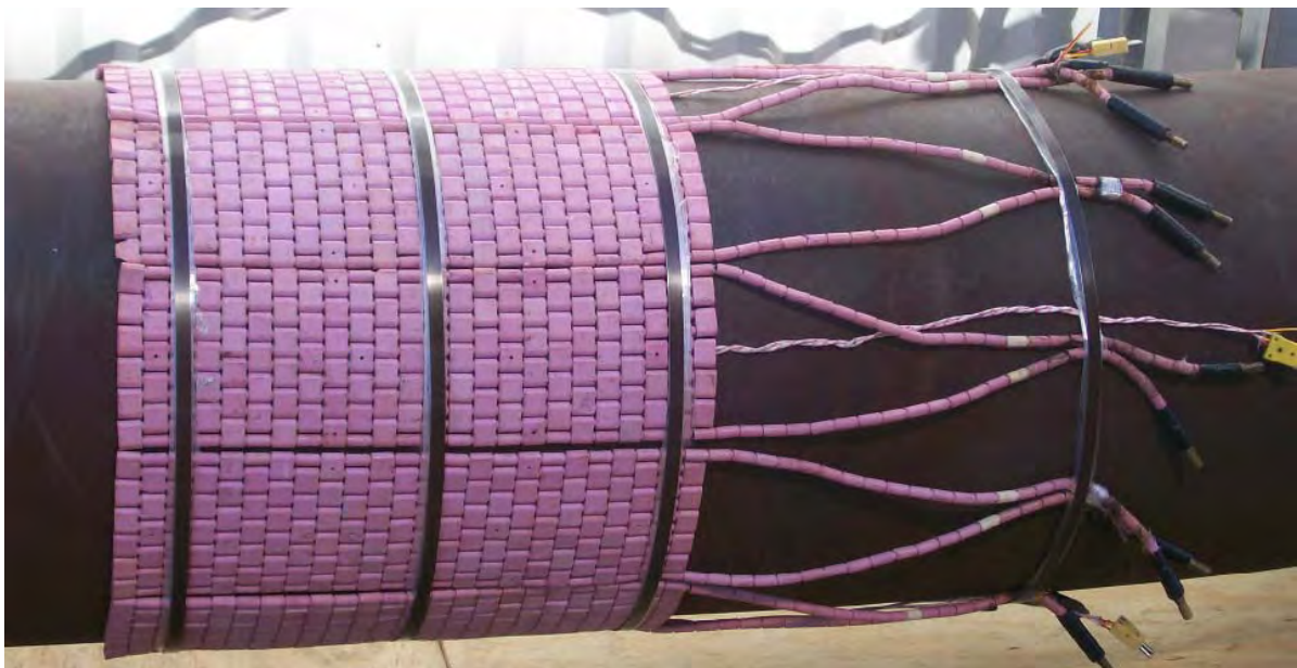
شکل-۲۰۰: تنش زدایی بصورت موضعی در سیستم لوله کشی صنعتی
