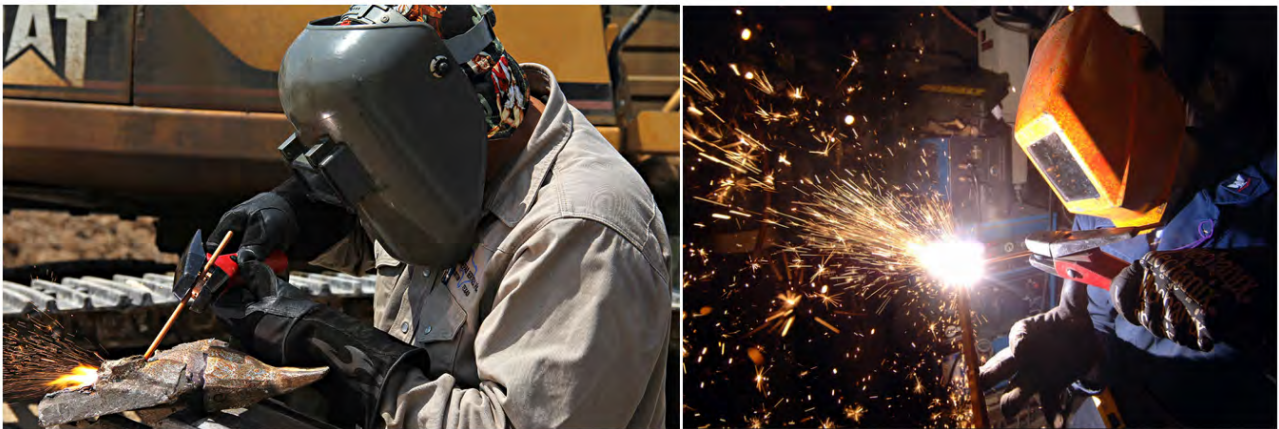
شکل-۲۴۹ : طریقه اجرای روش BACK GOUGING
