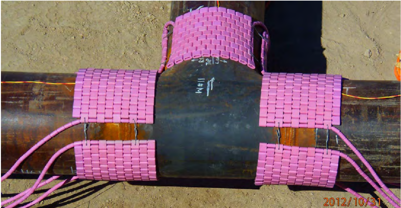
شکل-۲۰۳: تنش زدایی موضعی در سیستم لوله کشی صنعتی مثال (b): دما و زمان برای انجام عملیات حرارتی پس از جوشکاری در مشخصات فنی یک پروژه: جدول-۷۴: جدول عملیات تنش زدایی مطابق با Spec یک پروژه
