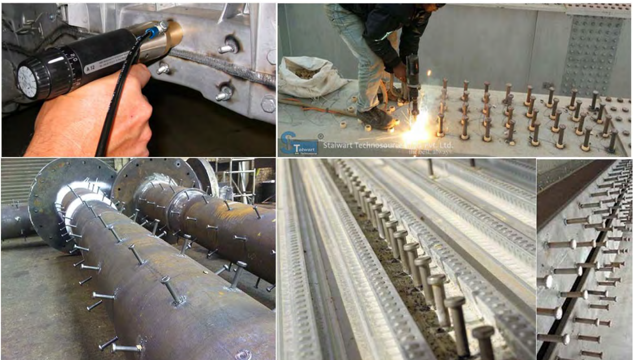
شکل-۴۵۲: جوشکاری میله ای Stud Welding
