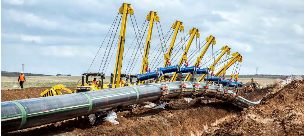
شکل-۴۶: اجرای خط لوله
