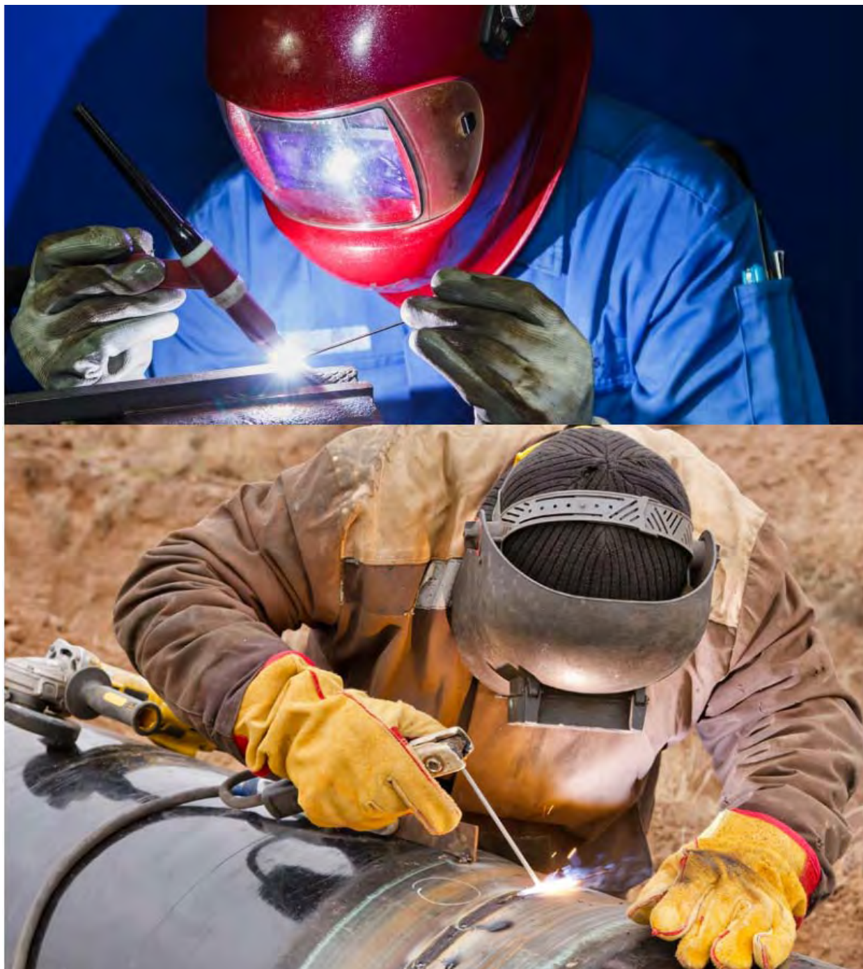
شکل-۳۴۳: نمایی از جوش GTAW و جوش SMAW در یک شکل
