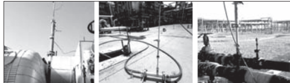
شکل ۲- نصب تجهیزات تزریق
