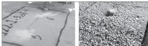
شکل ۳- نمونه نقاط نشتی علامت گذاری شده
