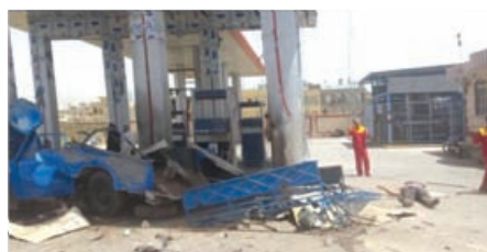
انفجار مخزن CNG خودروبی در جایگاه
