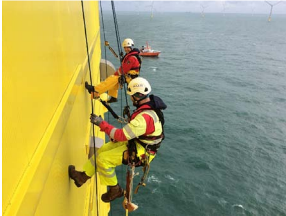
تصویر شماره ۲: عملیات کار با طناب - تاسیسات دریائی
