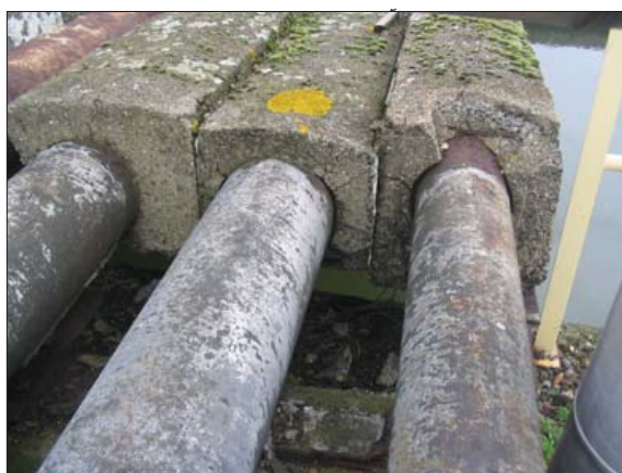
شکل ۵: لوله‌های توزیع محصولات نفتی که قسمتی از آن‌ها بالای یک مخزن در لوله‌های بتنی قرار دارد.
